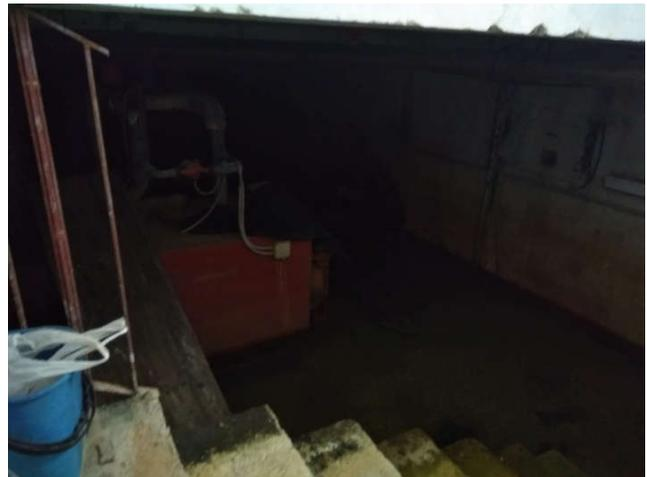
Tale ambiente attualmente è pieno d'acqua ad una altezza notevole coinvolgendo le strutture murarie e in c.a. ivi esistenti nonché una centrale termica in disuso e altro materiale vario (v. foto). Non sappiamo se lo scantinato è stato messo in sicurezza vista la presenza di prese e fili elettrici.
