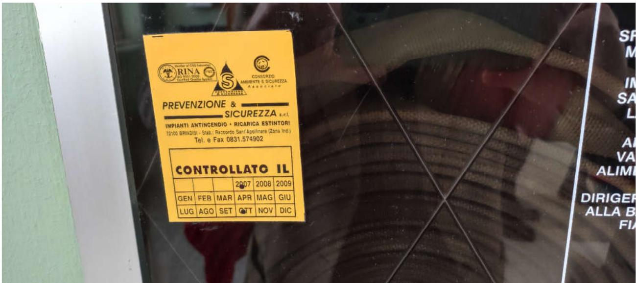
La sorveglianza delle attrezzature antincendio e in particolare la verifica dei vari **punti di controllo** (impianto di allarme, idranti, estintori, quadro elettrico generale, luci di emergenza, porte REI, uscite e segnaletica di sicurezza) viene effettuata **mensilmente** e i risultati dell'ispezione inseriti nel Registro dei controlli antincendio.
